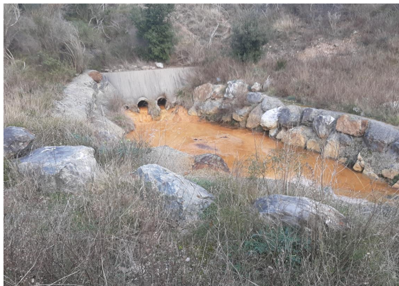
Figure 11 – Vue de la sortie des penstocks dans le bassin n°6
