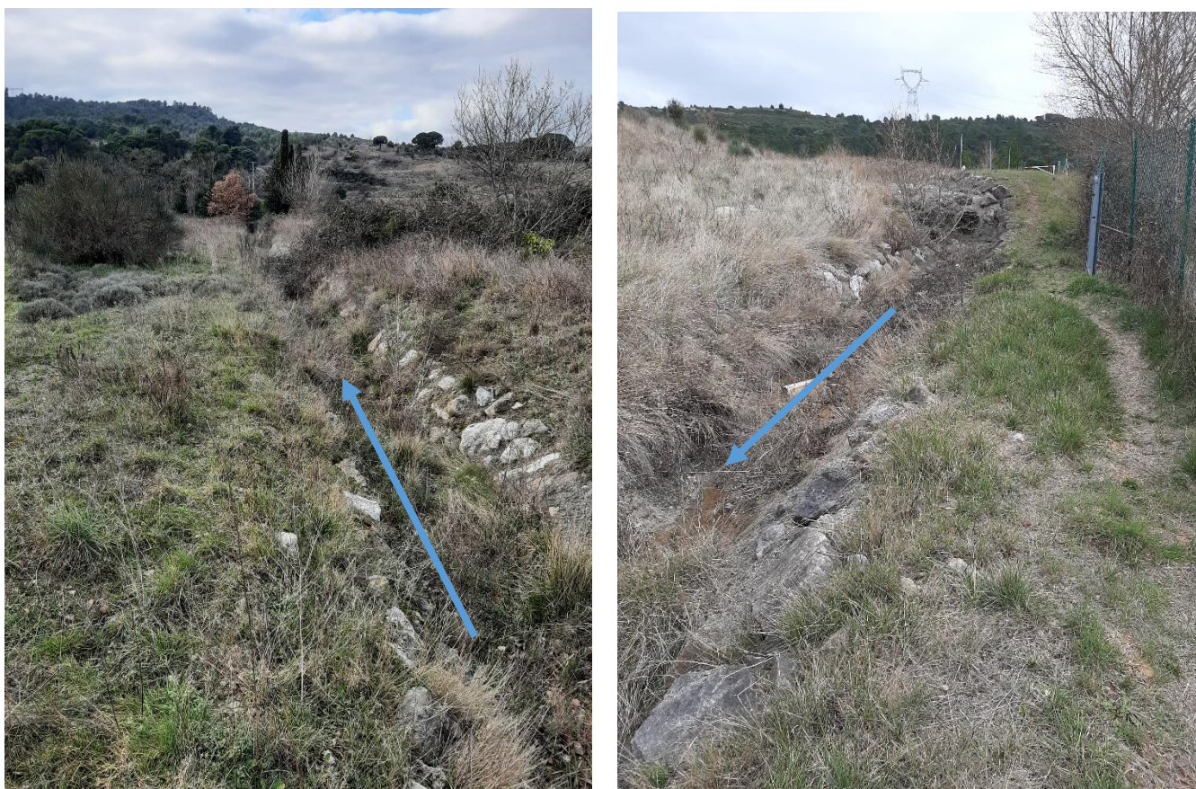
Figure 6 - Fossés de collecte des eaux pluviales
