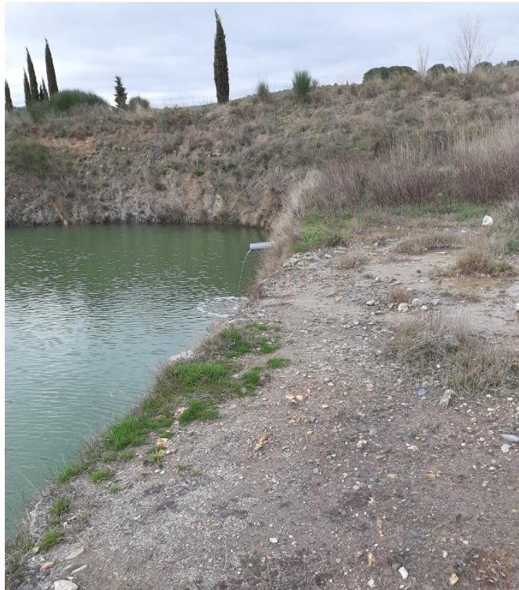
Figure 4 – Canalisation reliant les bassins entre eux (sur la photo canalisation reliant le bassin n°4 au bassin n°5)
